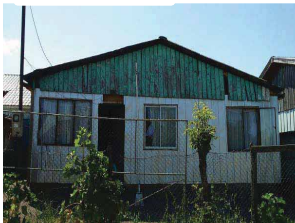
Vivienda sin solución habitacional
